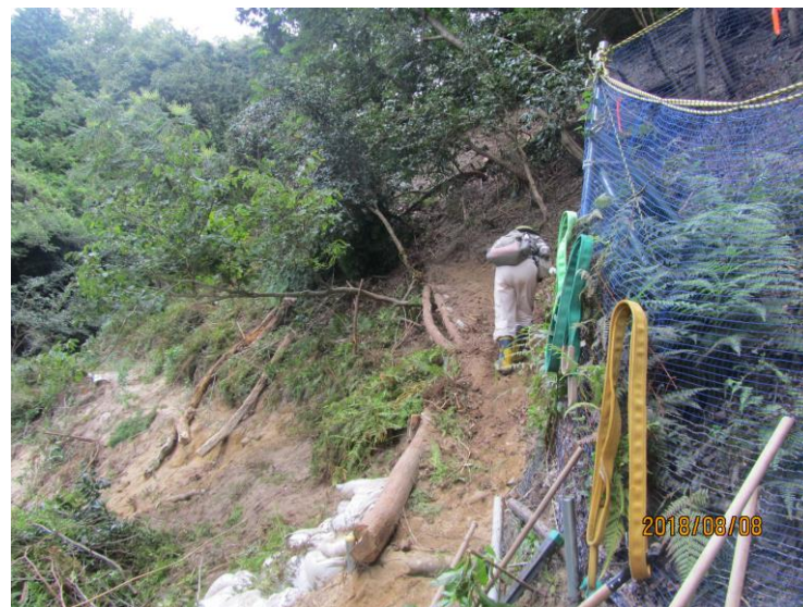
8/8作業 新しい作業道整備
