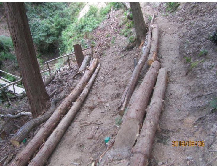
8/6作業 崩壊場所から杉丸太移動
